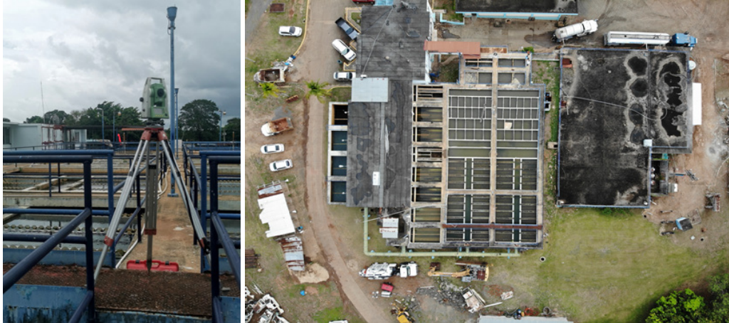
Fig. 2 Medición y rectificación In-Situ. a) Estación total marca Leica FlexLine TS06; b) Imagen aérea planta potabilizadora de la Chorrera
