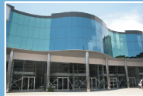
Las nuevas instalaciones del Edificio CIREBON PEAK, cuenta con locales comerciales, sala de ventas área de oficinas y bodegas.
