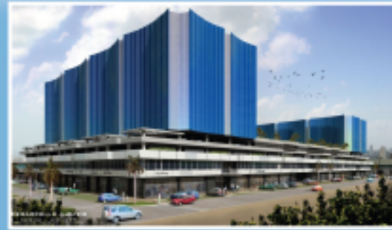
DESARROLLO 4 ALTOS, en su primera fase construye bodegas de almacenamiento. Su segunda fase, comprende locales comerciales, modernas torres de oficinas y más de 1,000 estacionamientos.
