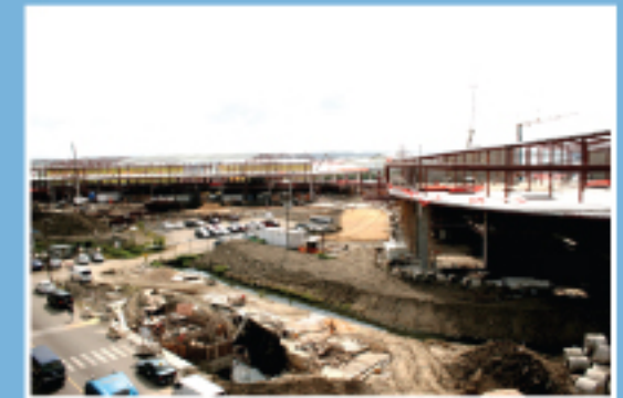
Avanza obra del proyecto INTERPLAZA, un nuevo concepto de locales tipo "mall", que construye dentro de 7 hectáreas edificio de dos plantas, salas de ventas y plaza de estacionamientos.
