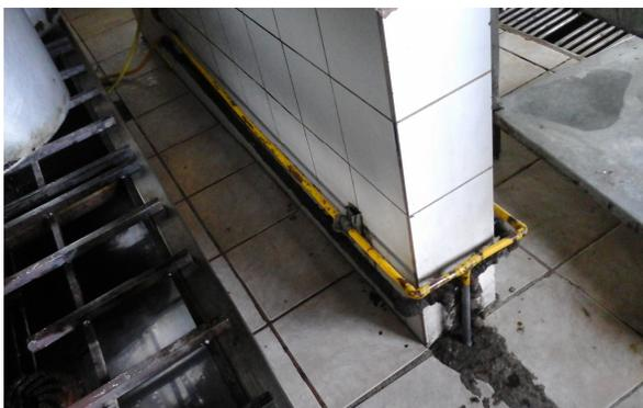
Figura 9. Tubería empotrada de GLP.
