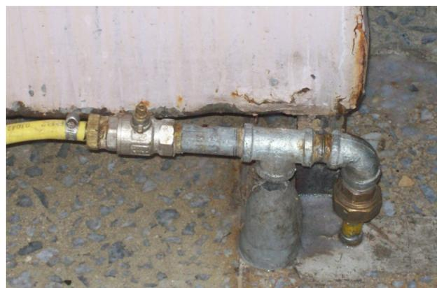
Figura 15. Falencias en instalación de tuberías de conducción de GLP.
