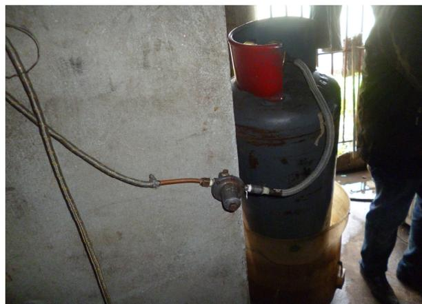
Figura 4. Cilindro al que se le “ayuda” a vaporizar.
