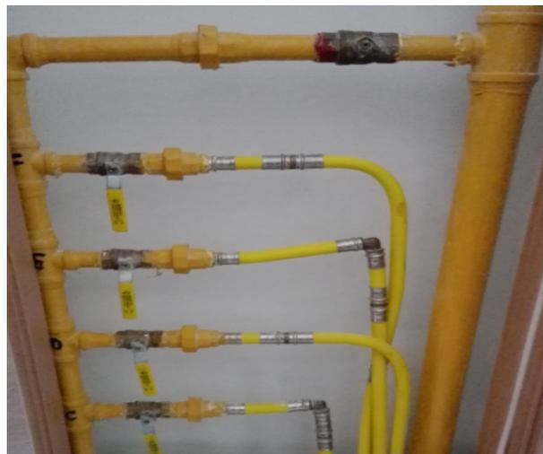
**Figura 7.** Tubería de P-Al-P instalada al interior de edificios.
