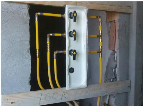
**Figura 6.** Tubería de P-Al-P instalada al interior de edificios.
