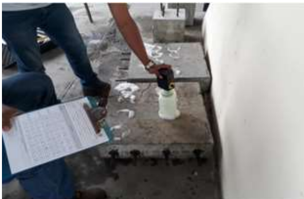
Figura 6. Ensayo de medición de potencial Fuente: elaboración propia
