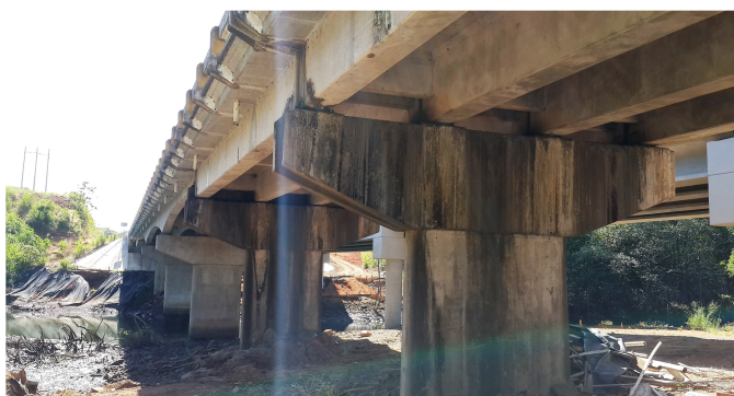
Figura 14. Vista bajo el puente 370750-925160.
