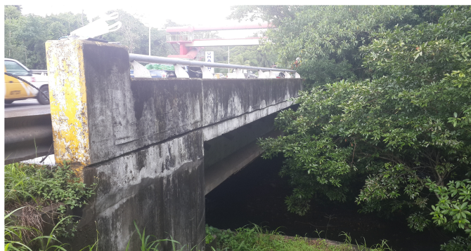
Figura 13. Vista bajo el Puente 340130-931970.
