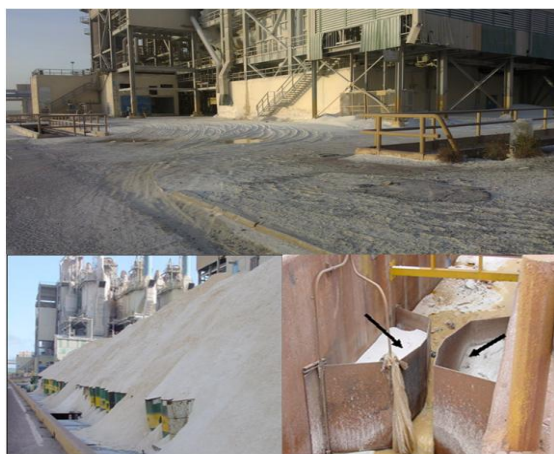
Figura 2. Sustancias químicas cáusticas y residuos de alúmina que llegan al canal perimetral.
