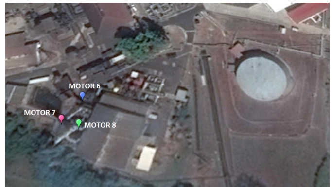
Figura 1. Localización de las chimeneas de los motores 6, 7 y 8 de la Planta Termoelectrica de Miraflores. Imagen de Google Earth.
