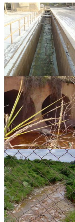
Figura 1. Vistas del recorrido del efluente a lo largo del canal perimetral dentro de la planta, túnel de salida y área de descarga.
