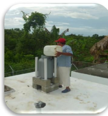
**Figura 4.** Vaciado de solución de hipoclorito de sodio al tanque dosificador para la desinfección del agua abastecida de la fuente natural en tanque de reserva o de almacenamiento.
