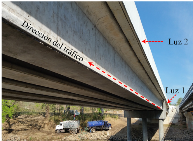
Figura 2. Vista del puente sobre el Río David aguas abajo.
