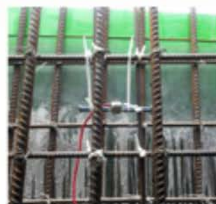
Figura # 2: Esquema de colocación de sensores en el puente segmental sobre el río Chico.
