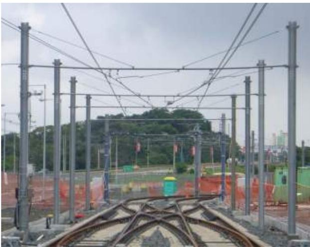
**Figura 3.** Postes de soportar catenarias. Ingeniería conceptual Línea 2. Especificaciones funcionales, técnicas y contractuales. Tomo II. Equipamientos [37].
