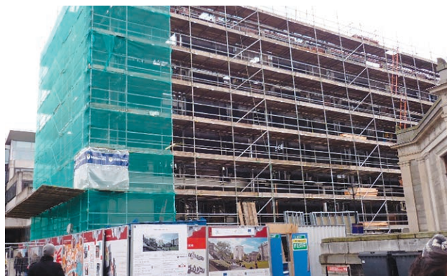
Figura 1. Edificio en proceso de readecuación estructural.
