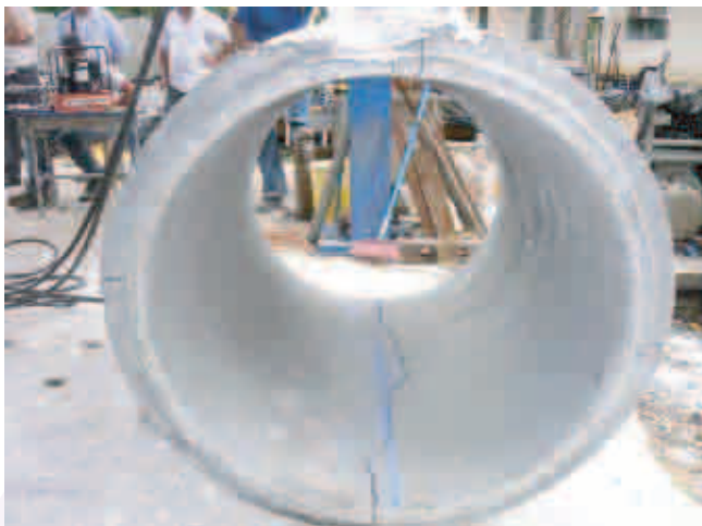
Falla de una tubería de concreto
