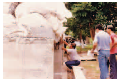
Prueba de postensado no adherido y adherido -Tesis de graduación-1987.
