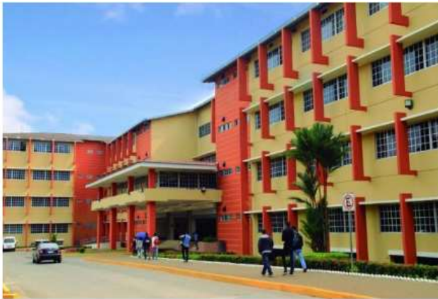
Figura 3. Edificio 1, Campus Víctor Levi Saso.
