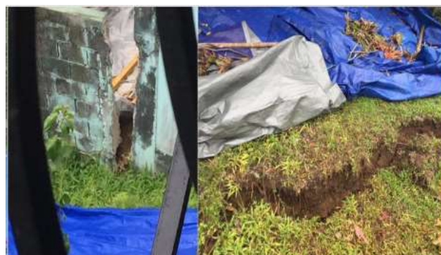
Figura 1. Casas con deslizamiento de tierra.
