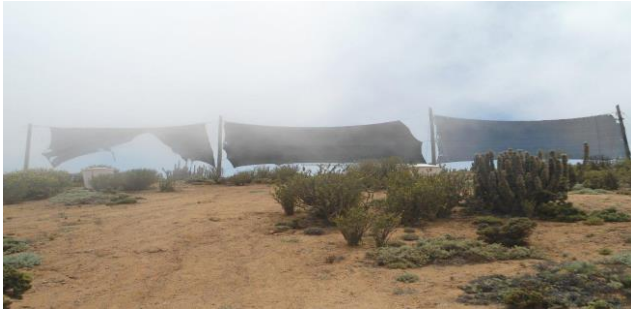
Figura 3. Atrapaniebla convencional deteriorada. Fuente: adaptado [4]
