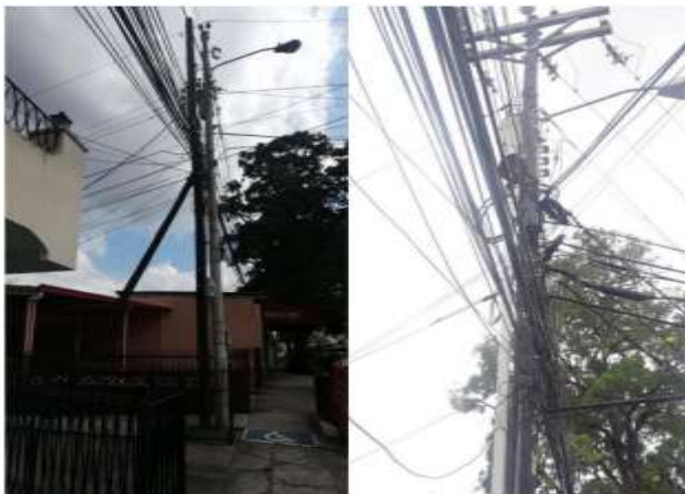
Figura 7. Postes actuales en el corregimiento de Bethania.
