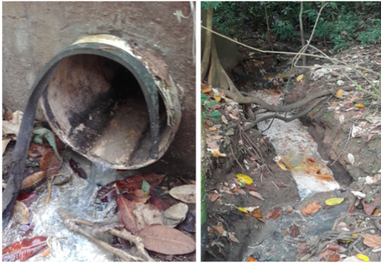
Figura 1. Punto de descarga de las aguas residuales grises de la cafetería del Edificio N.º 1.
