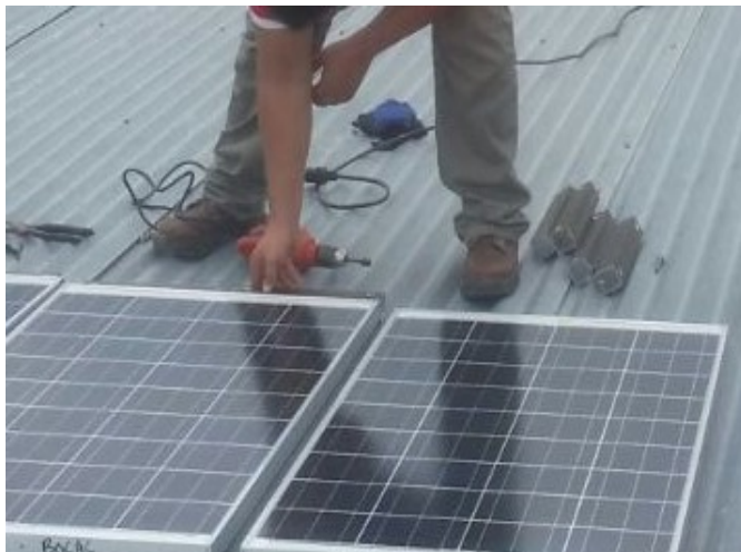
Figura 7. Instalaci n de placas solares.
