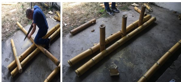
Figura 3. Medida, corte y colocación de elementos.
