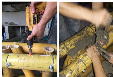
Figura 5. Proceso de perforación e inyección mortero.
