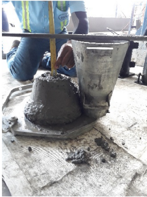
Figura 11. Prueba de revenimiento.
