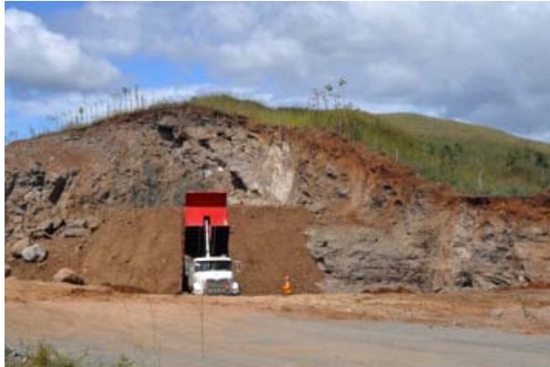
Figura 5. Corte de terreno.
