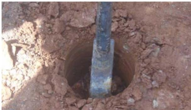
Figura 6. Barreno vertical en la corona del talud.
