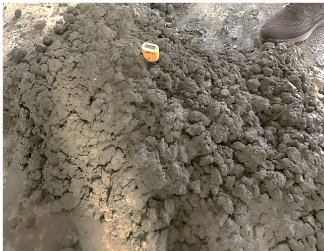
Figura 1. Mezcla de hormigón fresco.
