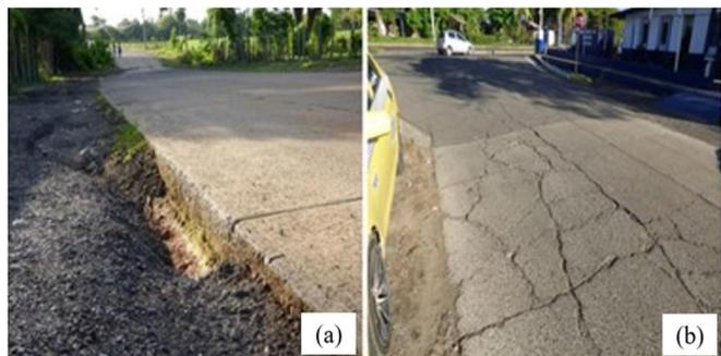
**Figura 5.** (a) Desnivel de hombro de severidad alta, (b) Losa dividida de severidad alta.
