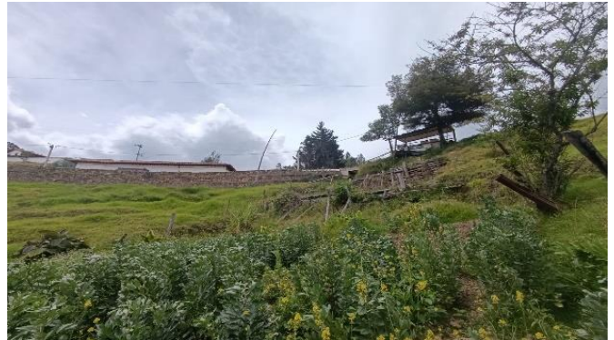
Figura 2. Lote en proceso de deslizamiento 2.
