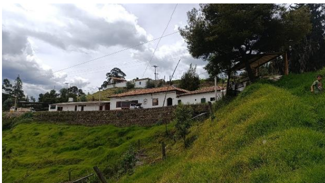
Figura 1. Lote en proceso de deslizamiento 1.
