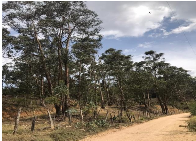
Figura 4. Desvío de la vía por deslizamiento.
