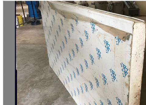
Figura 4. Paneles de poliestireno recubiertos de aluminios.
