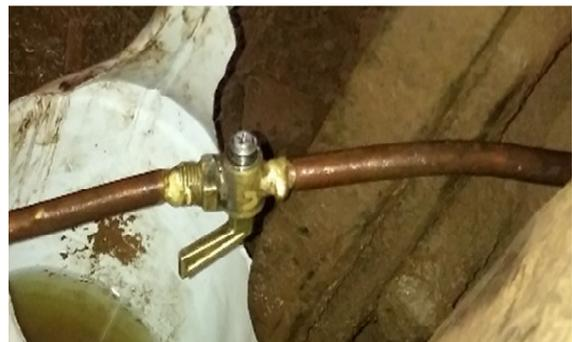
Figura 2. Válvula colocada para regular la cantidad de diésel aplicado.
