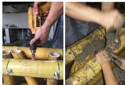
Figura 5. Proceso de perforación e inyección mortero.
