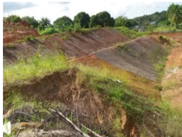
Figura 5. Talud a evaluar.
