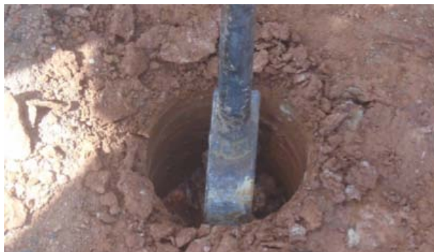
Figura 6. Barreno vertical en la corona del talud.
