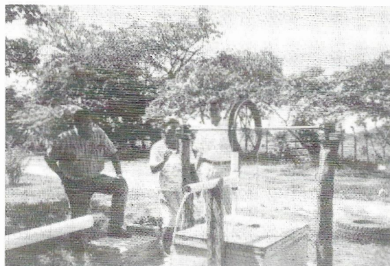
Figura N° 2. Bomba manual instalada en la Comunidad de Llano Marín en Penonomé.
