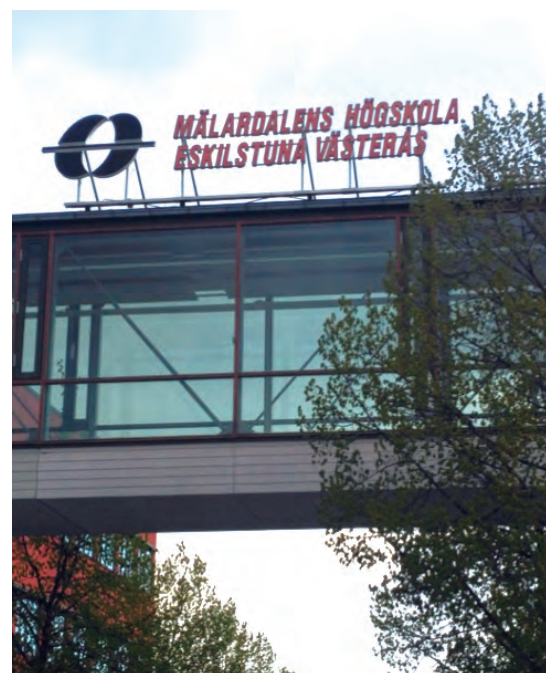
foto #10. Puente que une ambos edificios del Campus
