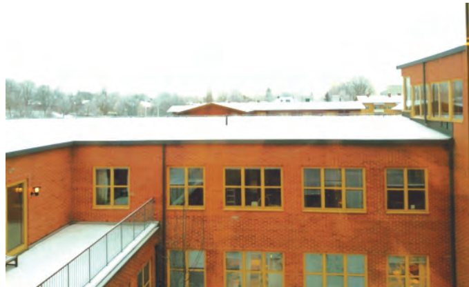
foto #4. Techo del edificio R, visto en invierno
