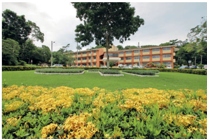
Figura 1: Vista frontal del edificio 2
